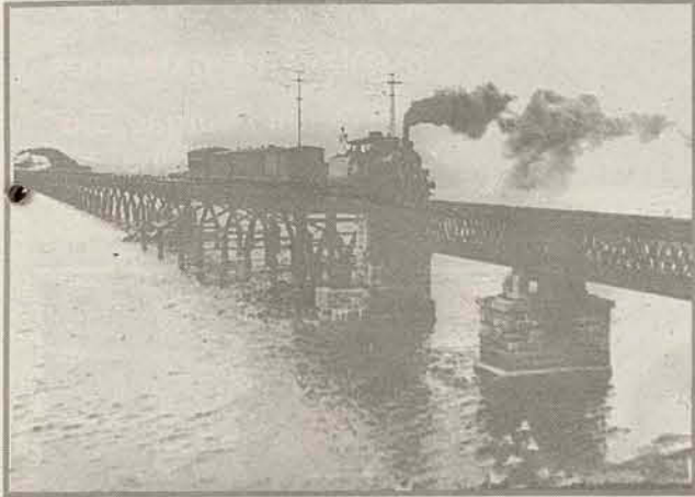
Ponte ferroviária de Cabeçuda, em 1935.
